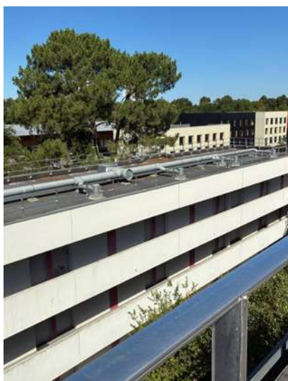
Résidence Ausone : mise en place de garde-corps
