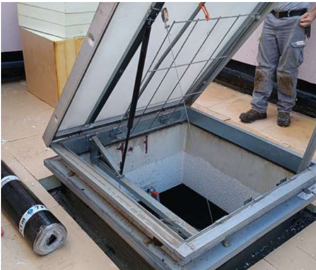
Pose de l'isolant autour d'un lanterneau
