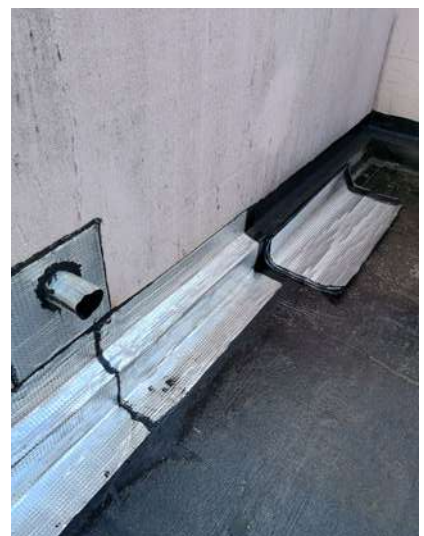
Réfection des relevés d'étanchéité (en cours)
