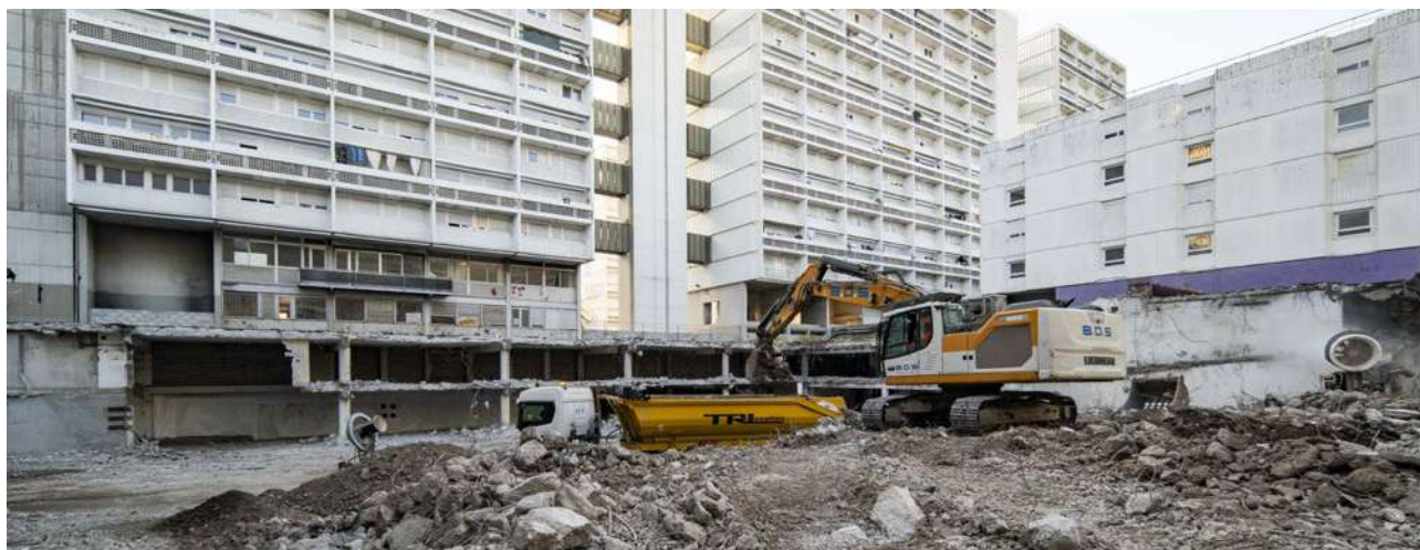
Démolition de la dalle
