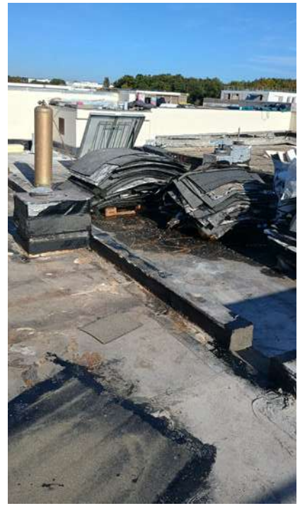
Dépose du complexe d'étanchéité
