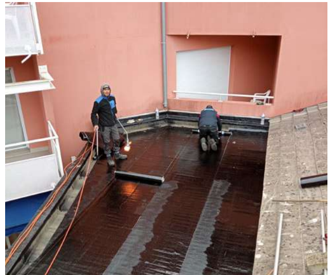
Pose étanchéité bitumineuse
