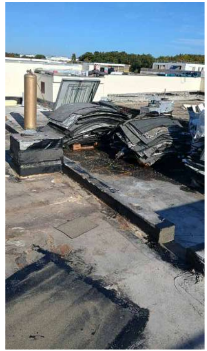
Dépose du complexe d'étanchéité
