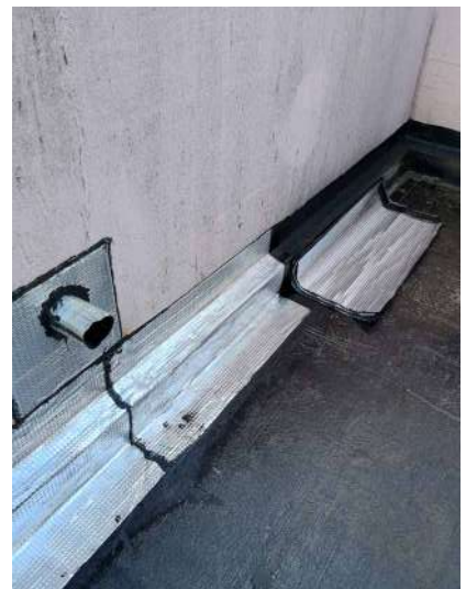
Réfection des relevés d'étanchéité (en cours)
