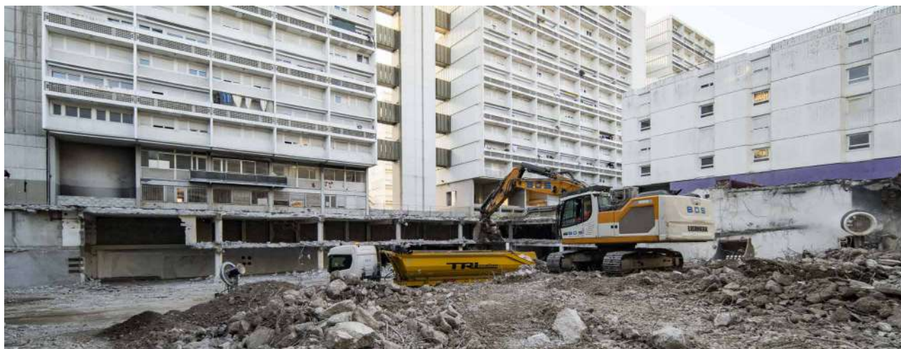
Démolition de la dalle
