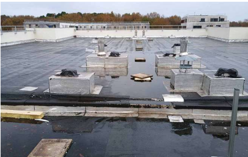
Réfection du complexe avant protection lourde et avant repose de la ventilation
