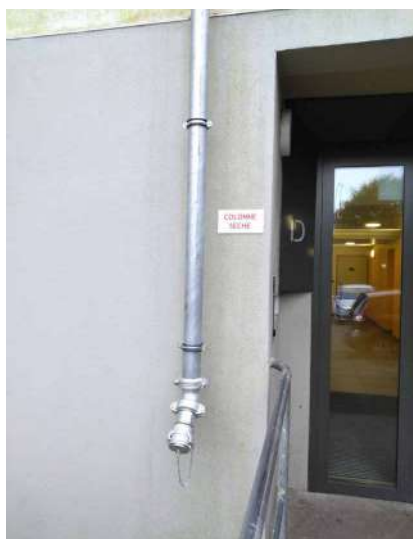
Résidence Solesse : mise en place d'une colonne sèche sur les bâtiments D et E
