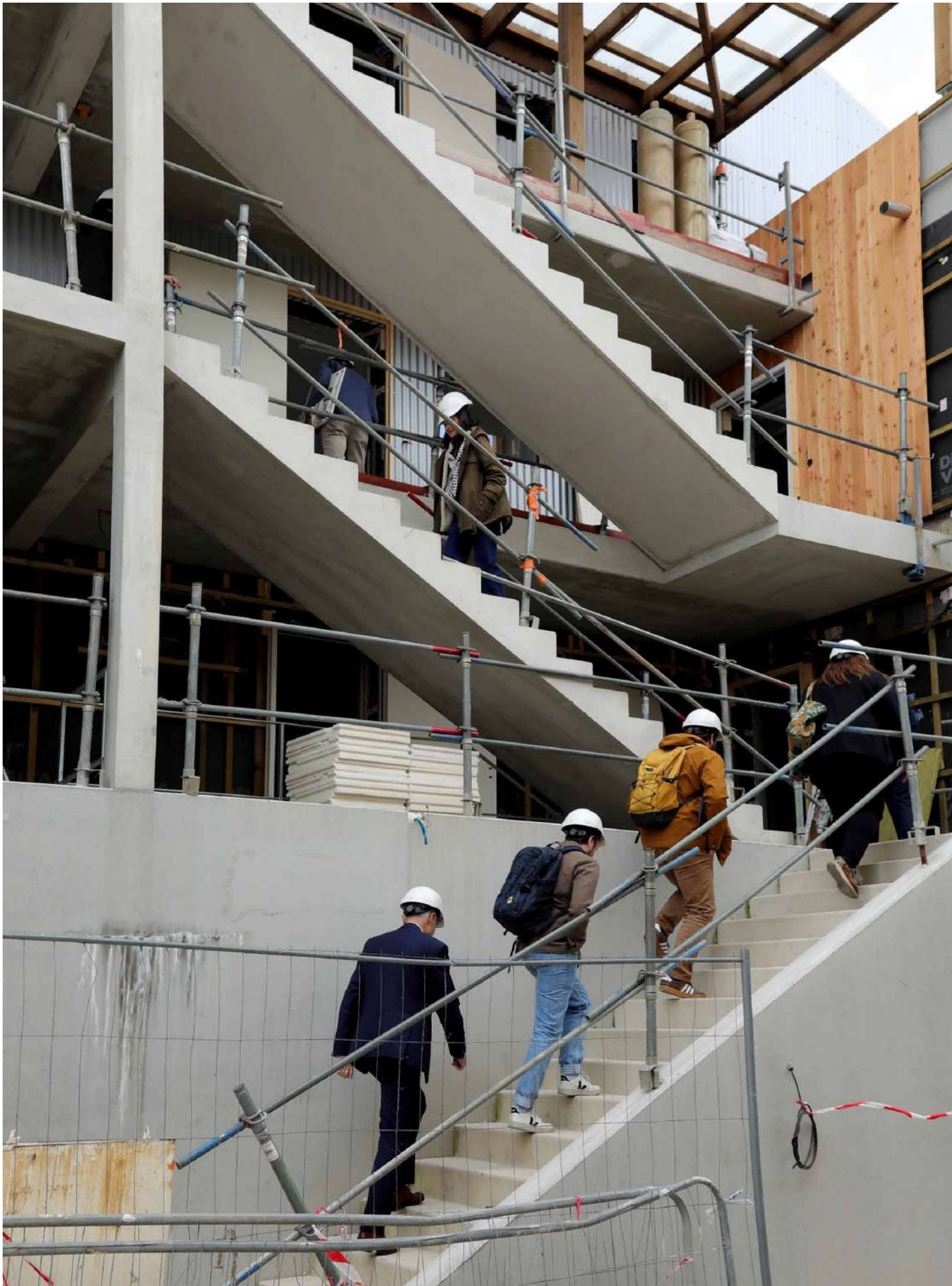
Visite du chantier de la résidence Paul Boncour à Bordeaux-Bastide par des élus et des agents de plusieurs communes de la métropole bordelaise engagées dans la démarche Nouvelles formes urbaines d'habitat .
