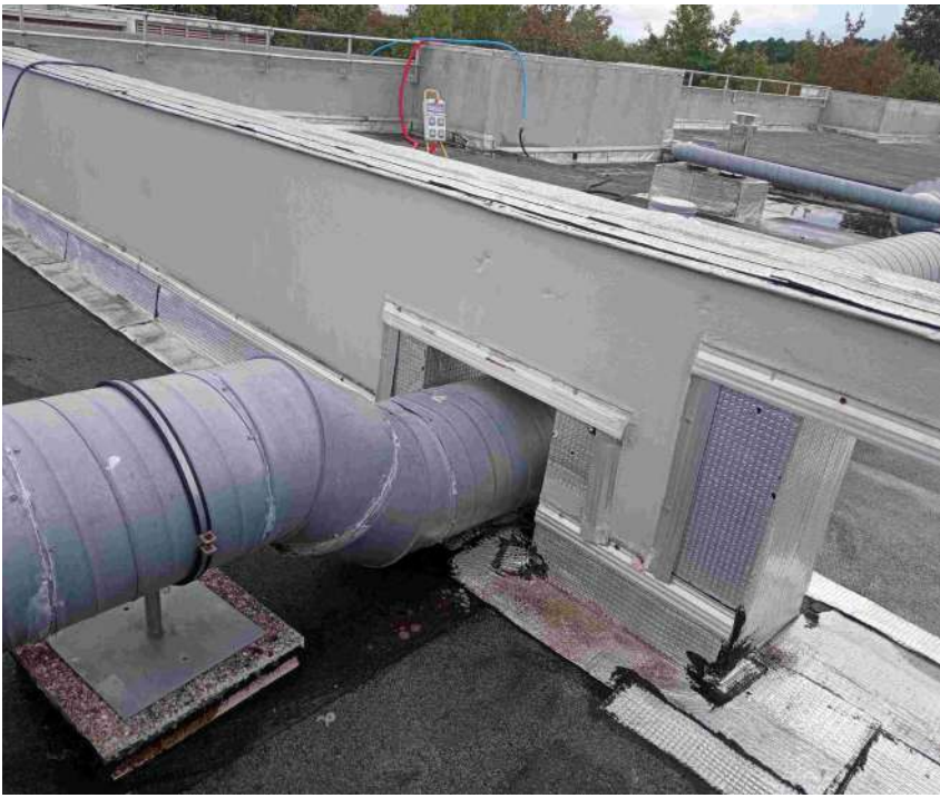
Installation de VMC et traversée de JD (point singulier avant travaux)
