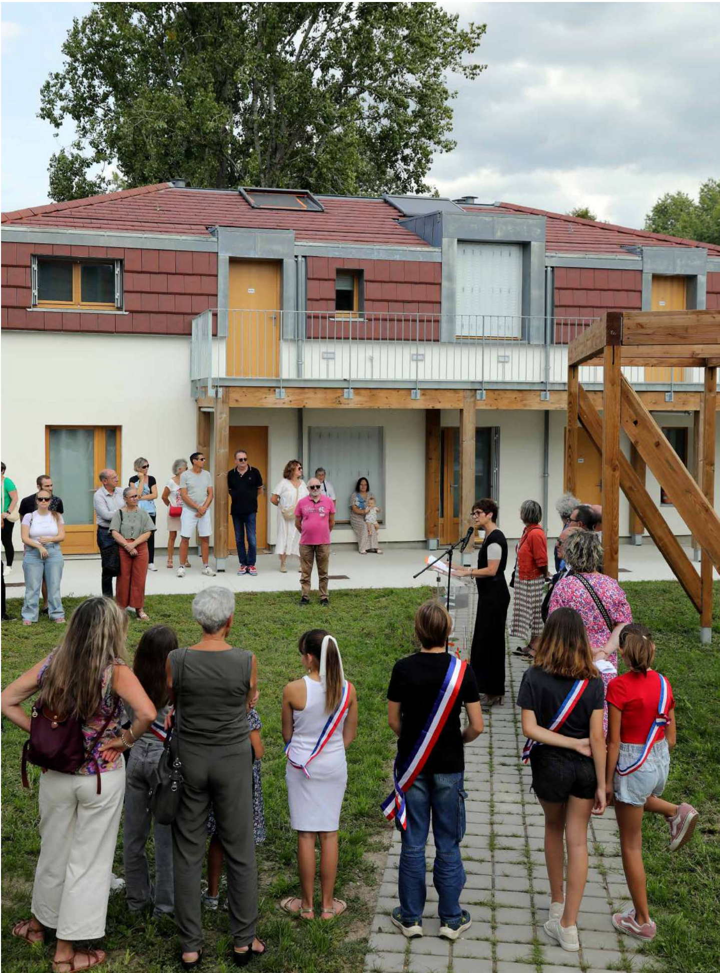
Septembre 2025 : inauguration de la résidence intergénérationnelle Le Hameau des Familles à Castelnau-de-Médoc.
