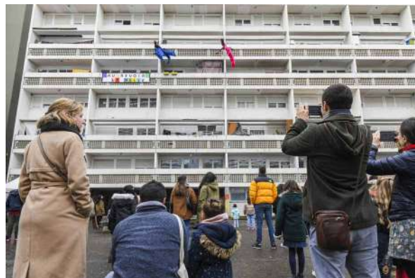
Une dernière fois sur la dalle
