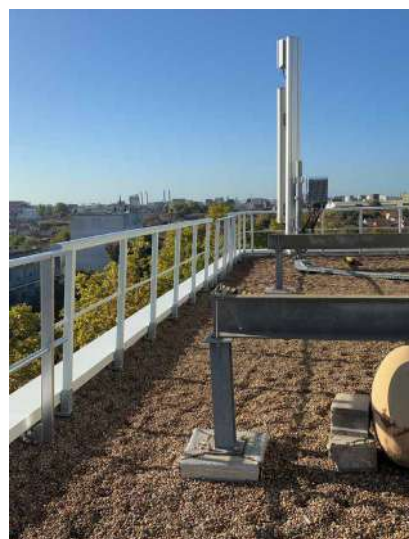
Résidence Blanqui : mise en place de garde-corps en lien avec les opérateurs téléphoniques
