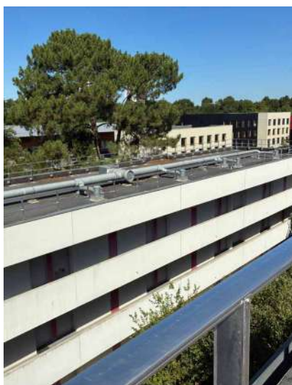
Résidence Ausone : mise en place de garde-corps
