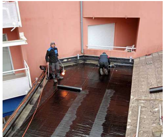
Pose étanchéité bitumineuse
