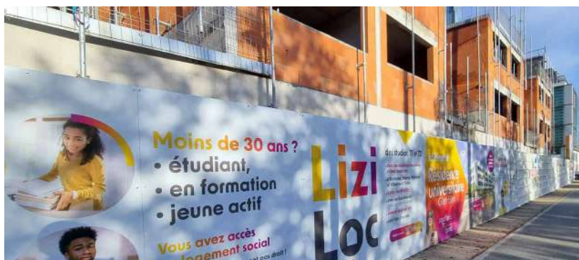
La résidence universitaire Glen Ellyn en chantier au Bouscat. Livraison prévisionnelle : 3 ème trimestre 2026
