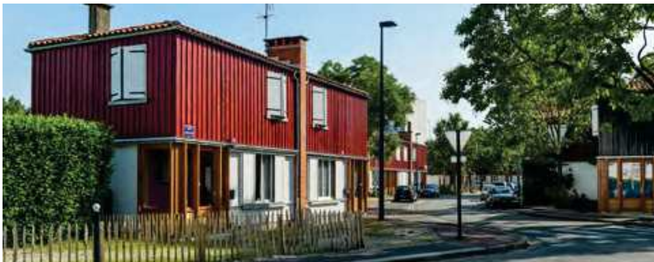
La Cité Claveau dans le quartier de Bacalan à Bordeaux
