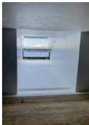
232 rue Sainte-Catherine à Bordeaux : mise en place d'un exutoire de désenfumage
