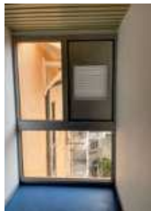
Mise en place d'une ventilation haute
