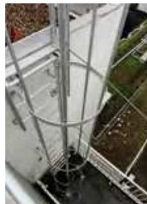
Les Aubiers à Bordeaux : mise en conformité des équipements en toiture
