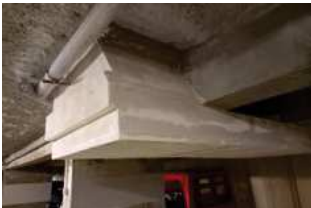
Création d'un conduit de ventilation basse
