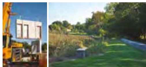
De gauche à droite : Chantier d'assemblage d'une maison à ossature bois. Parc public paysager aménagé à proximité du ruisseau du Desclaux
