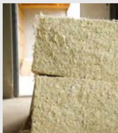
Isolant biosourcé sur le chantier de la résidence Sylvaé
