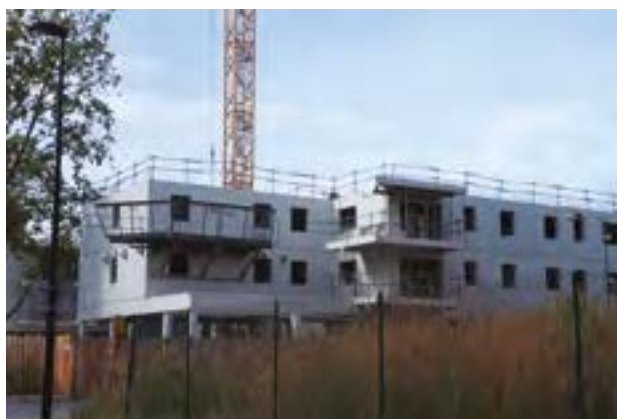
Chantier de construction de la résidence solidaire intergénérationnelle Aldéa
