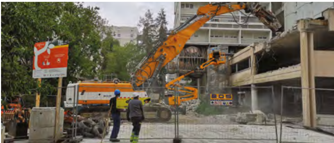
Démolition de l'ancien siège d'Aquitanis, cours des Aubiers
