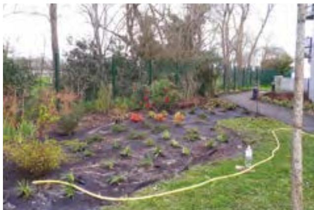
Chantier d'amélioration à la résidence Le Péséou (Le Bouscat)
