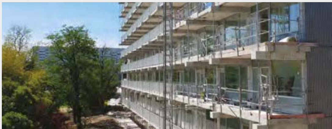
Chantier de la résidence Orizon à Mérignac, respectueux de la Charte Chantier Propre
