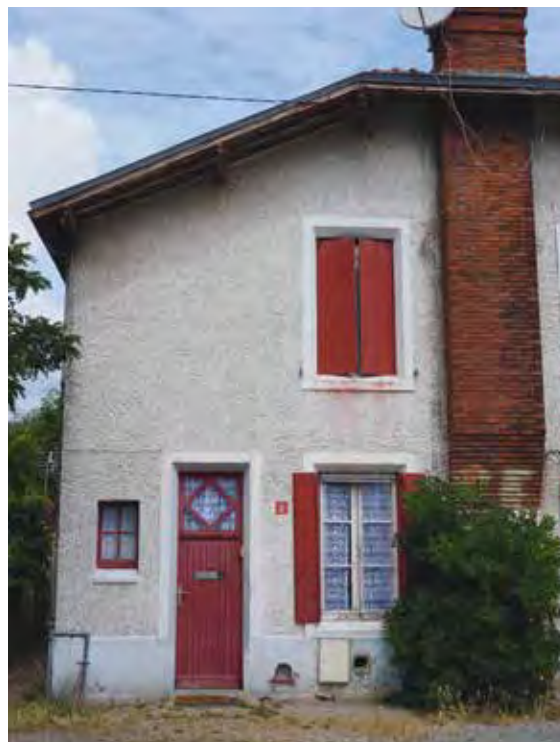
Maison ouvrière des années 1930 de la cité Paul-Boncour
