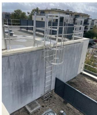
Allée de Ravel : mise en place de garde-corps et d'échelles à crinoline
