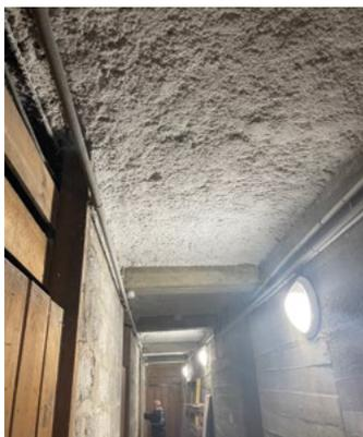
Résidence Édouard Vaillant : flocage et mise en place de blocs sécurisés
